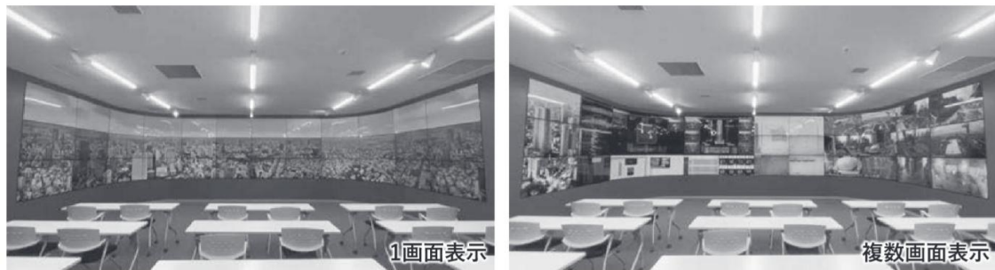
図 3.1 清水建設の「コントロール・センター」
